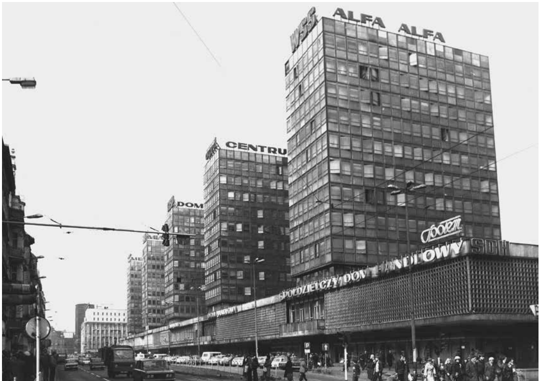
8. Zespół DTC „Centrum” ul. Święty Marcin, 1992 (MKZ. Fot. J. Miecznikowski) 8. DTC “Centrum” complex. Saint Martin Street. 1992
