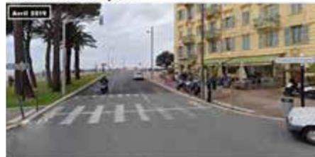
Ce cas d'étude est le résultat de la création d'une bande cyclable en d'une bande prétrama. Ces bande bidirectionnelle des deux côtés de la chaussée mis en service en mai 2020, a nécessité la neutralisation d'une voie de circulation dans chaque sens.
