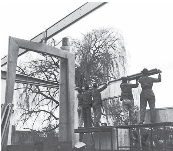
Jean Prouvé, Pierre Lefèvre: Dokumentation der Errichtung eines vorfabrizierten Hauses in Saarbrücken, o. D. Jean Prouvé, Pierre Lefèvre: Documentation de la construction d'une maison préfabriquée à Sarrebruck, s. d.
