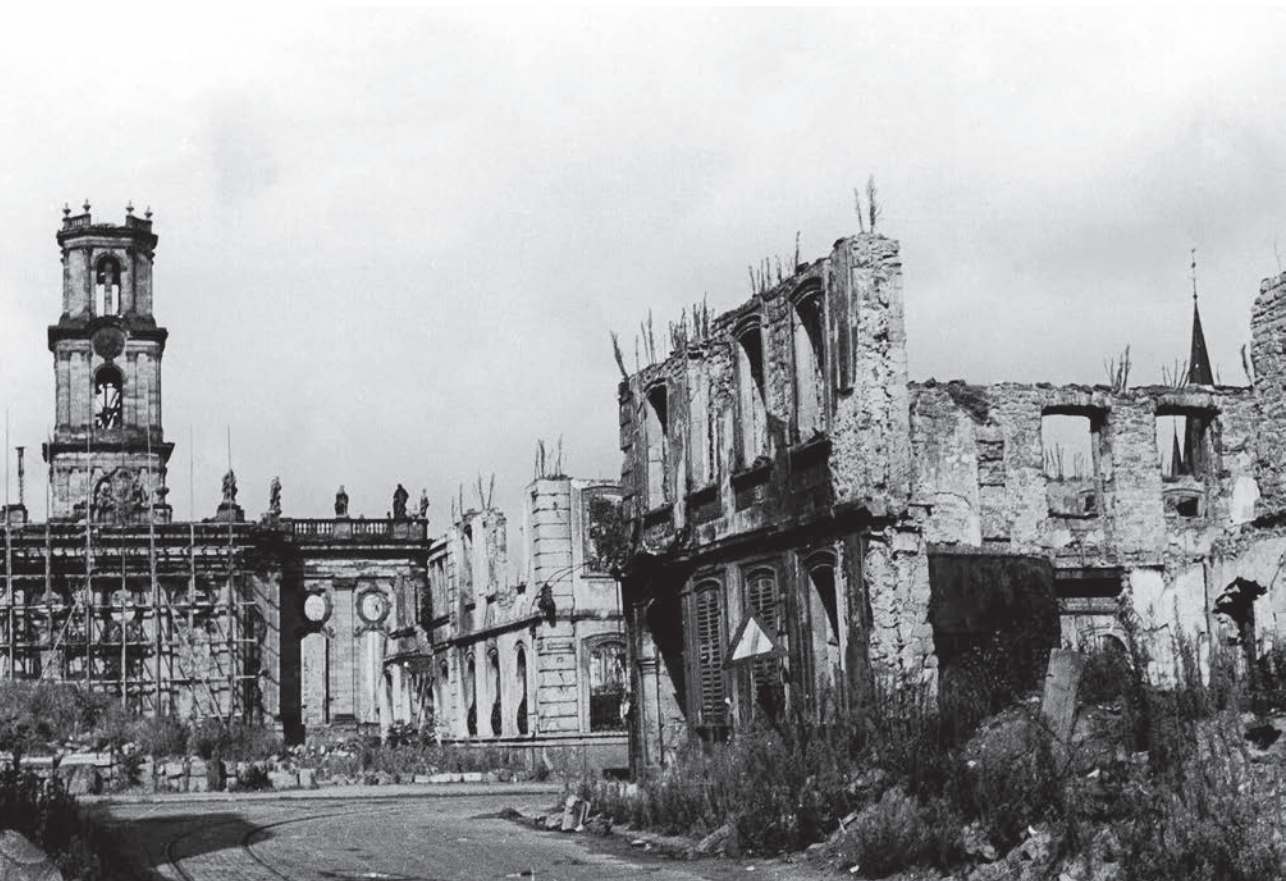
Zerstörte Ludwigskirche und Palais, Saarbrücken, 1945 L'église de Louis et le palais en ruines, Saarbrücken, 1945
